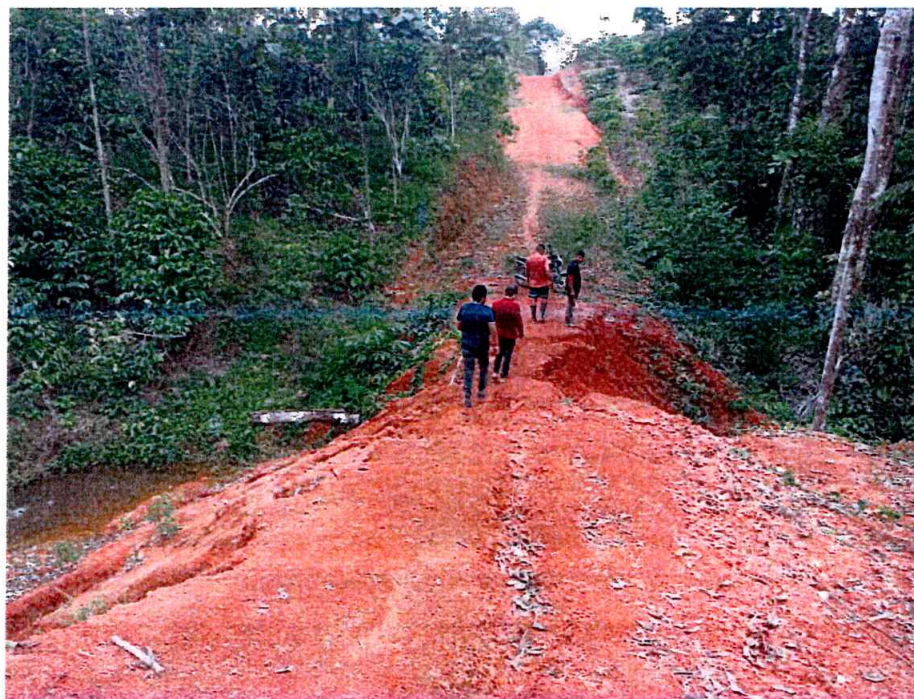
Foto No. 2: Paso de agua #1, comunidad Las Mercedes
