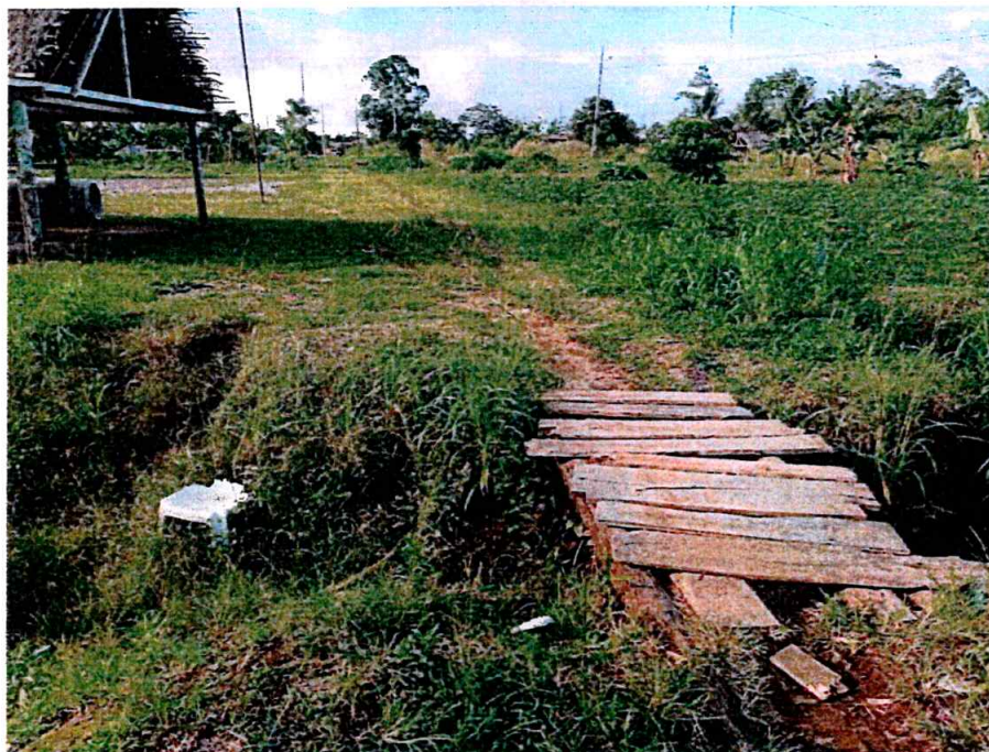
Foto No. 1: pasos de agua Tres de Noviembre.
