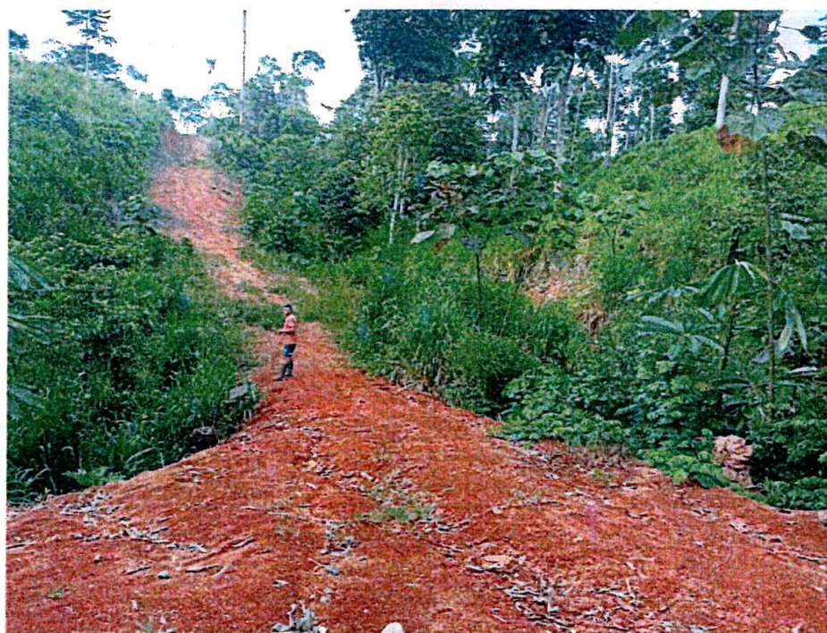
Foto No. 3: Paso de agua #2, comunidad Las Mercedes
