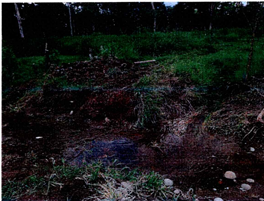
Foto No. 4: Paso de agua #4, comunidad 25 de Diciembre
