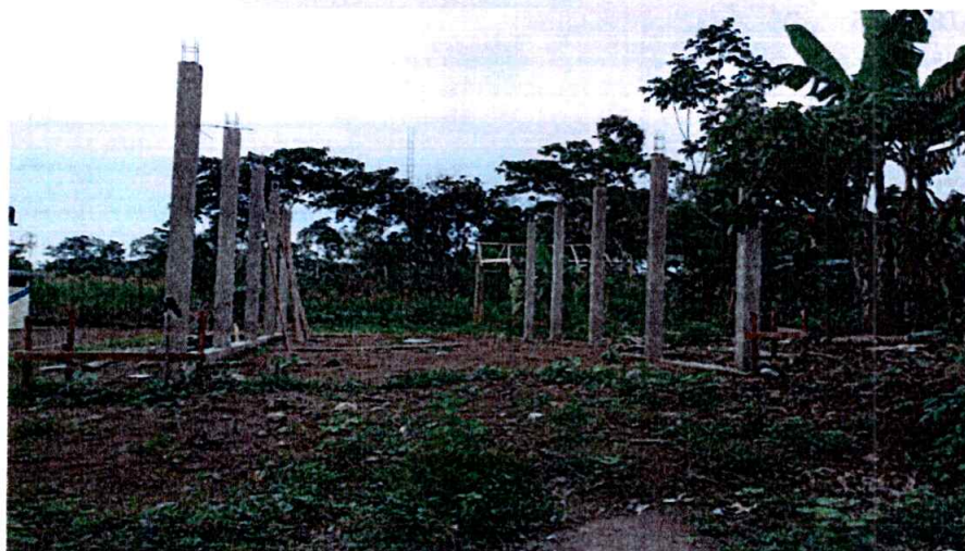
Foto No. 2: Estado Actual Casa Taller.
