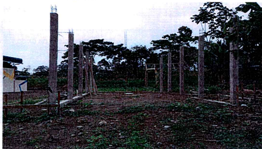
Foto No. 1: Estado Actual Casa Taller.
